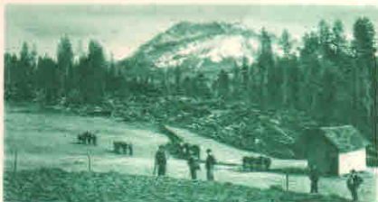
STURMSCHÄDEN IM ENTLÉBUCH
